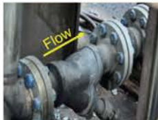
รูปที่ 1 Y-strainer แบบเหล็กหล่อ ติดตั้งอย่างถูกต้องในท่อสแตนเลสแบบเชื่อม
