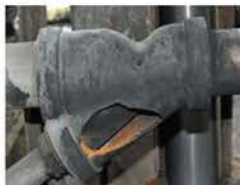
รูปที่ 1 Y-strainer แบบเหล็กหล่อ ติดตั้งอย่างถูกต้องในท่อสแตนเลสแบบเชื่อม
